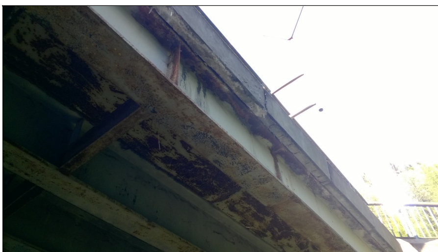
Projevy zatékání pod římsami
