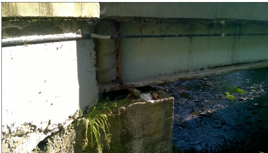
Detail uložení NK na spodní stavbu, uchycená vegetace na úložných prazích
