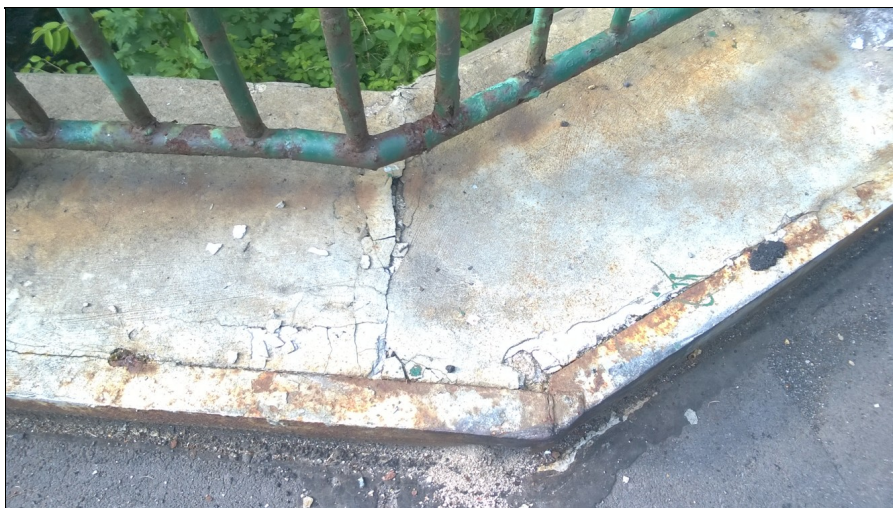
Poruchy říms a PKO zábradlí
