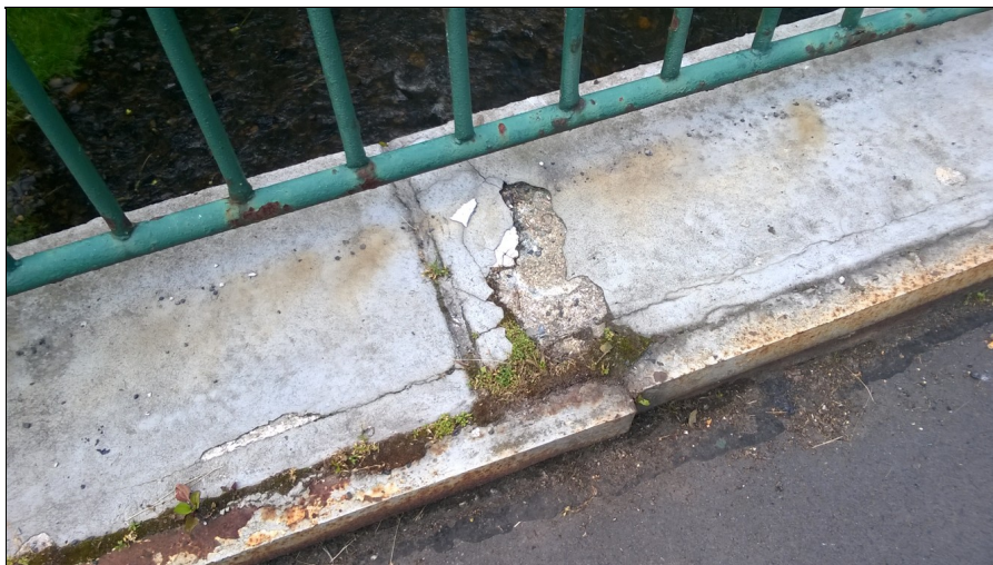
Poruchy říms a PKO zábradlí
